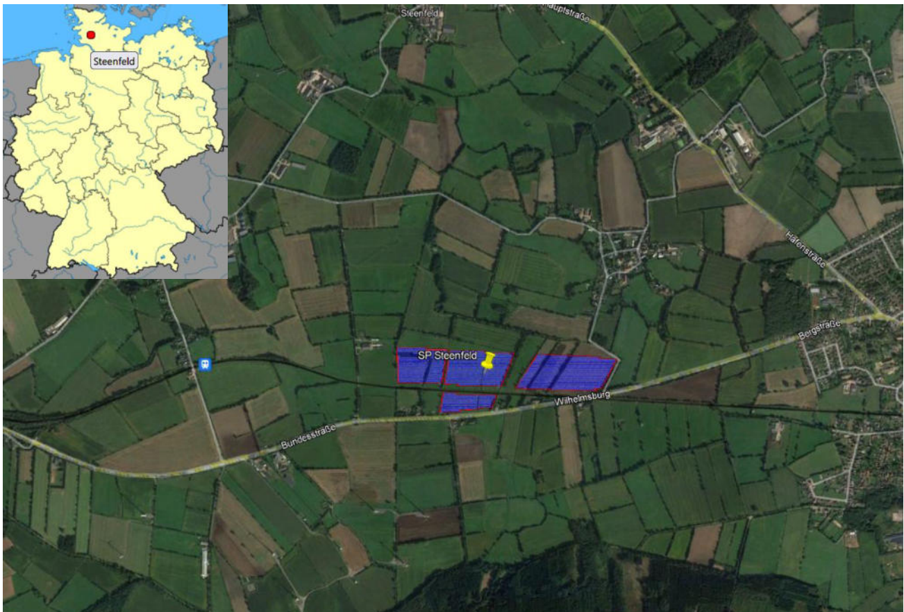
Bild 2.1.1: Luftbild mit Schema der PV Anlage (Quelle: Google Earth/SolPEG)
